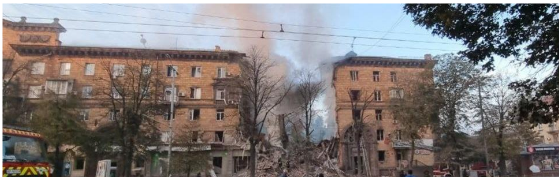
Рисунок 4.10. – Будинок на пр. Соборному 151 після прямого потраплення боєприпасів в м. Запоріжжі
